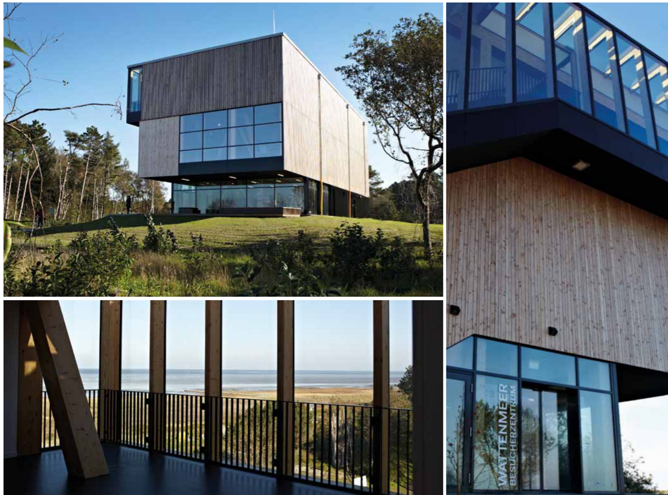
Besucherzentrum Wattenmeer, Cuxhaven
